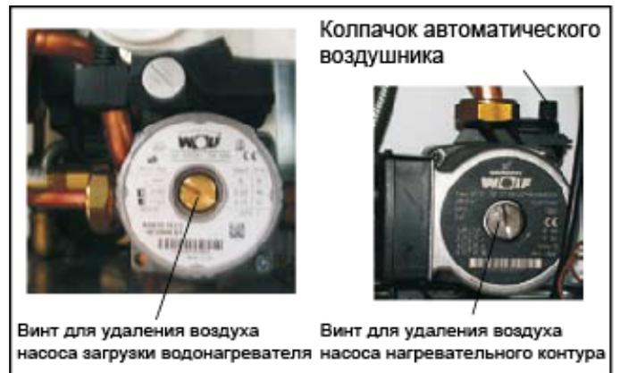
Рис.: Удаление воздуха из насоса контура отопления и насоса загрузки водонагревателя
