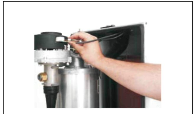
– Отсоединить штекер электрода ионизации (датчика пламени) и электрода поджига.
