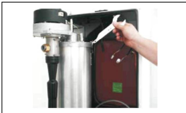
– Снять крышку камеры сгорания в направлении вверх.
