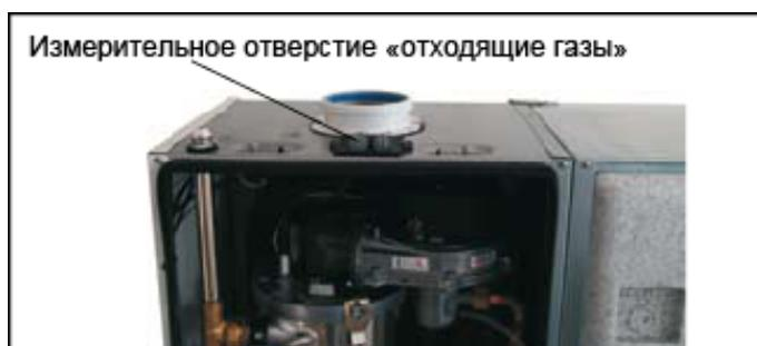
Рис.: Измерительные отверстия на открытом котле
