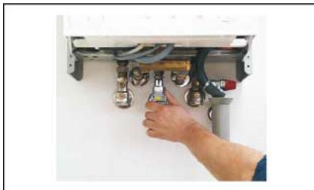
– Освободить обшивку, повернув правый и левый ригель. Освободить обшивку снизу, и, приподняв ее вверх, снять.
