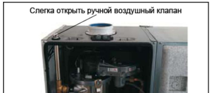
Рис.: Воздушный клапан с ручным управлением
