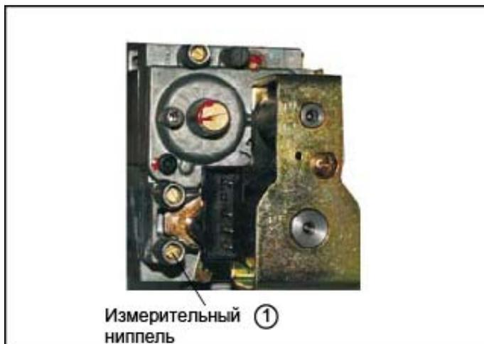
Рис.: Контроль давления подключения газа
