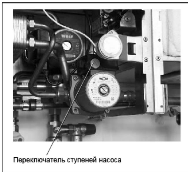
Рис.: Переключатель на насосе загрузки водонагревателя
