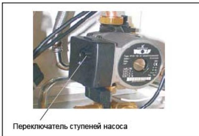
Рис.: Переключатель ступеней на 3-ступенчатом насосе котлового контура
