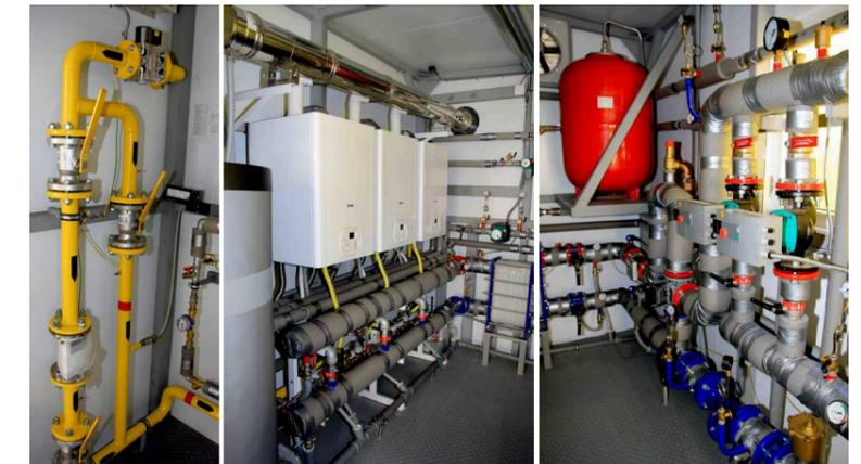
Система каскадная в модульном исполнении (КСМ) — оборудование для автономного теплоснабжения жилых, административных, общественных и производственных зданий и сооружений. Представляет собой строительный модуль, внутри которого смонтированы от 2 до 24 газовых отопительных аппаратов единичной мощностью 32 кВт или 50 кВт или 95 кВт.
