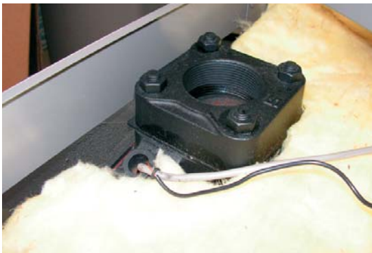
Рис. 13.16: Ввод датчиков в кожух
