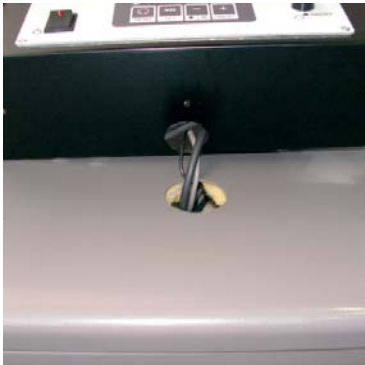
Рис. 13.13: Отверстие прохода покрытия
