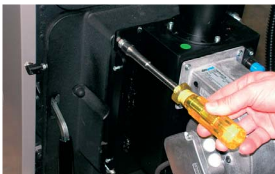
Рис. 13.11: Установка горелки
