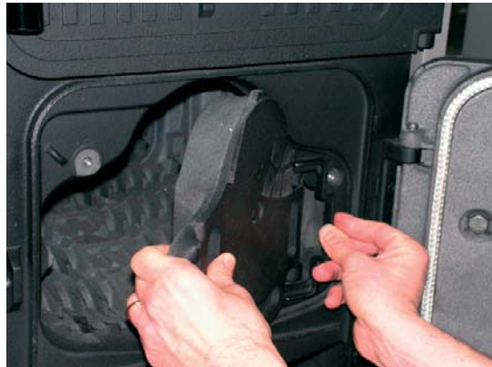
Снятие решетки. 13.1: Демонтаж решетки
