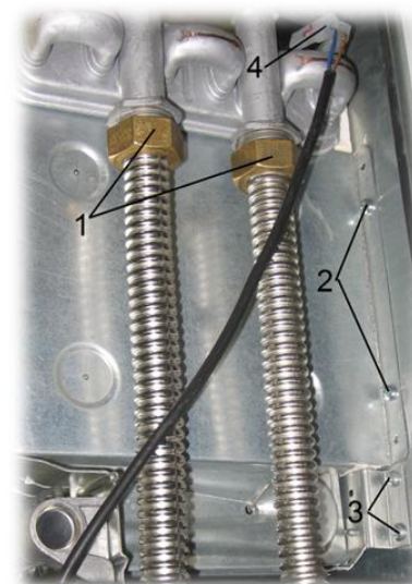
Рис. 15. Демонтаж горелки
