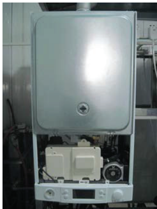
5. Снимите переднюю панель..
