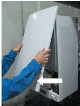
4. Поднимите вверх и снимите переднюю панель.
