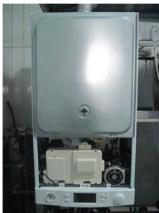
5. Снимите переднюю панель..
