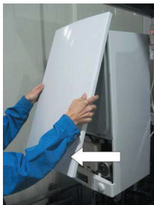
4. Поднимите вверх и снимите переднюю панель.
