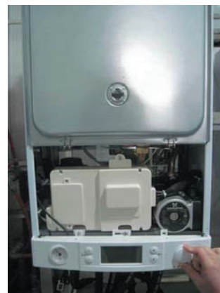
6. После подключения воды, газа и электропитания проверьте работоспособность котла.
