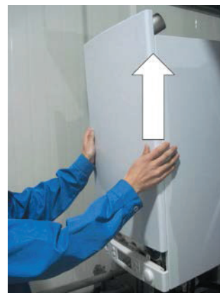
3. Передвиньте переднюю панель вверх и вперед.
