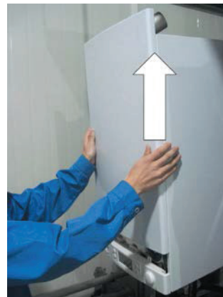
3. Передвиньте переднюю панель вверх и вперед.
