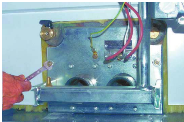
рис. 20 - Демонтаж горелок
