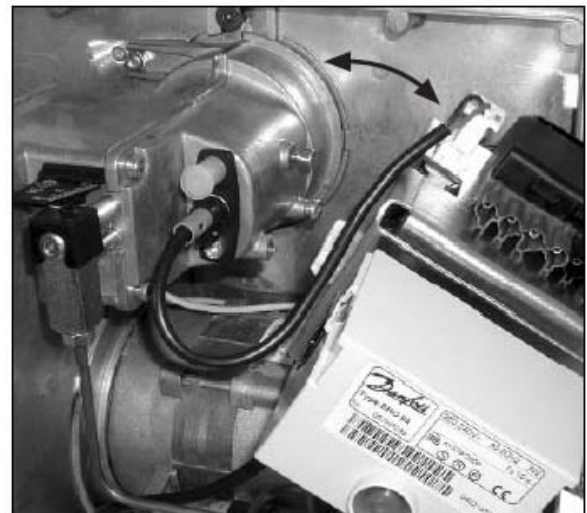
Рисунок 30 – Снятие блока управления
